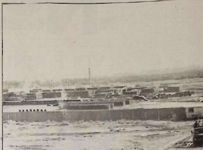
No canteiro da Estação de Tratamento, onde as fundições já estão prontas
