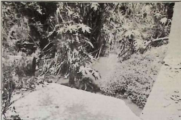
Impedido entre muros e mato, o valão ameaça causar novos problemas no Mutuá
