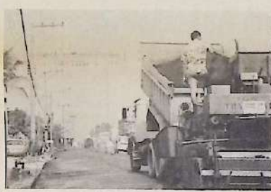
A obra vai facilitar o acesso à BR 101 e ao Centro da cidade.
