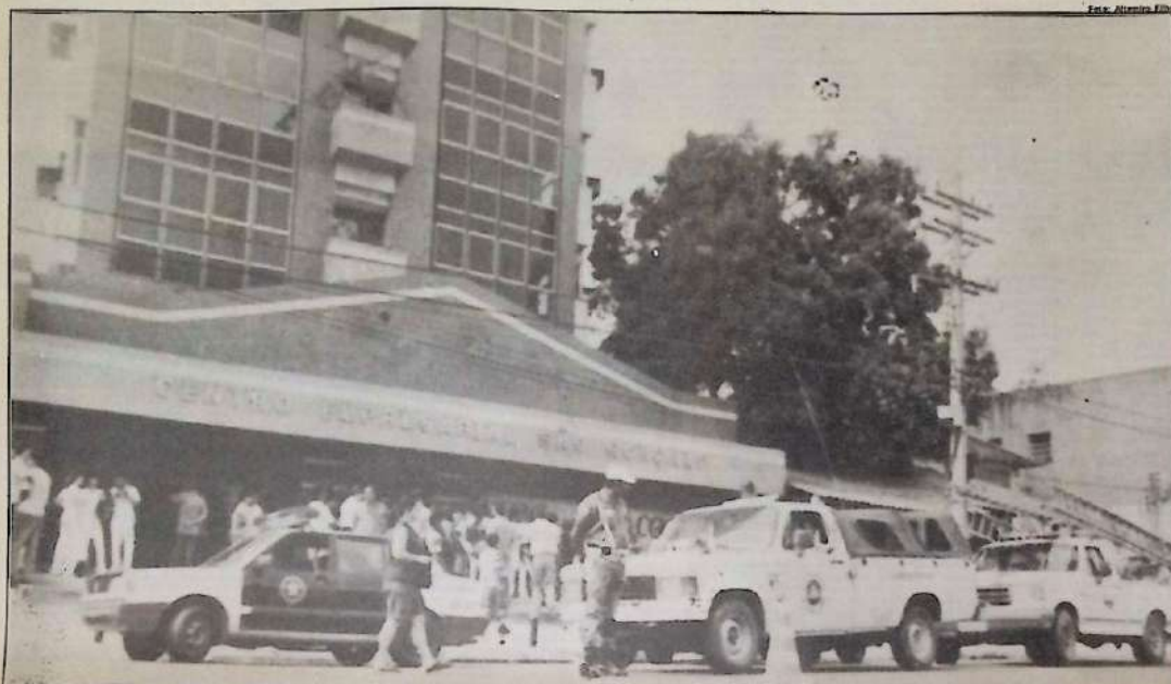
A EXPLOÇÃO ocorreu no térreo, próximo à portaria do edifício comercial
