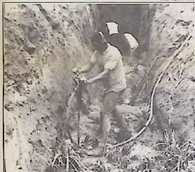
As obras estão sendo feitas nos bairros Jardim, Paraíso e Barro Vermelho, entre outros.
