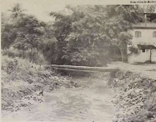
Construções ilegais causam o entupimento de rios, provocando inundações
