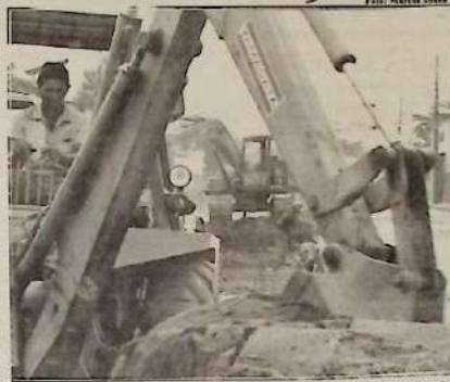
A sinalização vai ser feita tão logo terminem as obras de alargamento
