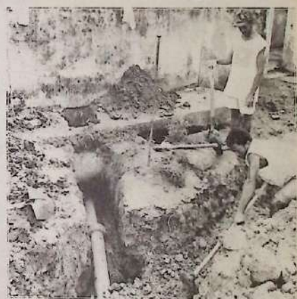
A rede de esgotos está sendo feita em vários bairros da cidade
