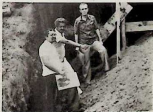
Aí está o Prefeito Adilio Pimentel em companhia do dr. Luciano Bastos e do representante da Revista ÚNICA, quando visitavam as obras da nova tomada d'água.
