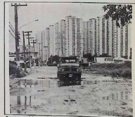
O entra-e-sai dos caminhões pipa destruiu o asfalto
