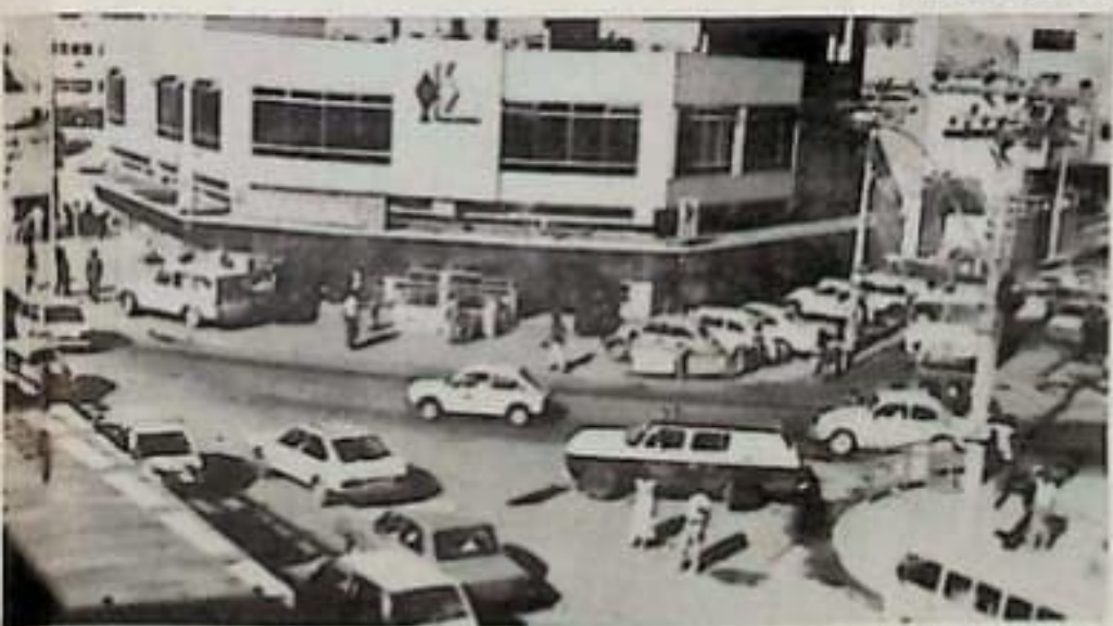
Trecho principal de Alcântara.
