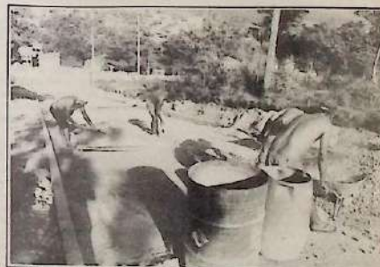
As obras constam da pavimentação
