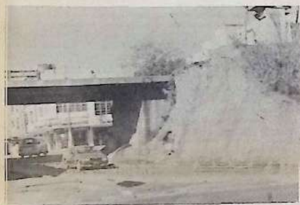
Agora falta a construção do piso do viaduto sobre a Avenida Maricá
