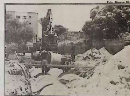
Os grossos tubos receberão toda a carga da rede de esgotos.
