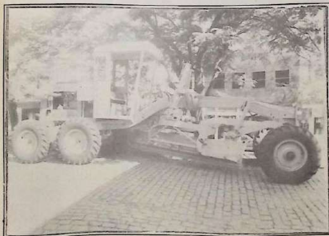
A recuperação das máquinas pesadas, foi o ponto de partida para colocar a Secretaria de Obras em condições de realizar o grande programa de realizações que a equipe de Arismar Dias recebeu do prefeito João Bravo. As primeiras frentes de trabalho, já estão em ação.
