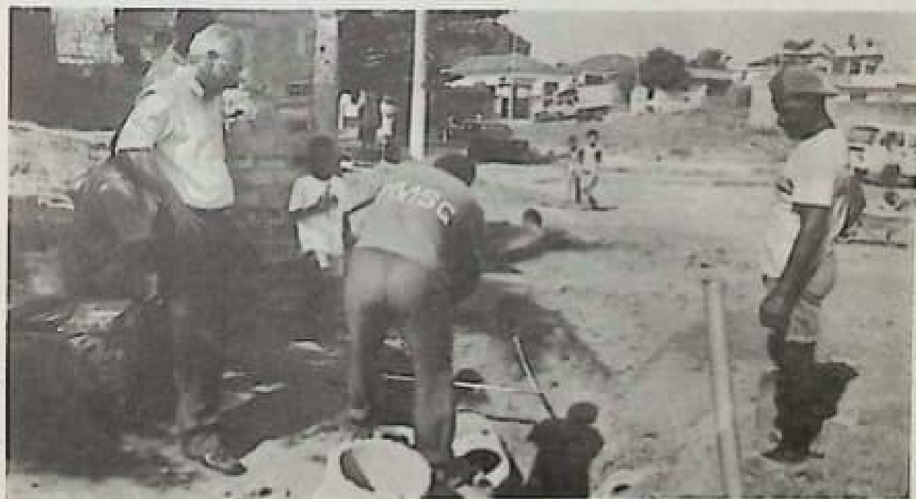
Na Rua Cândido Bastos, em Gradim, Bravo acompanha as obras realizadas em sistema de matão.
