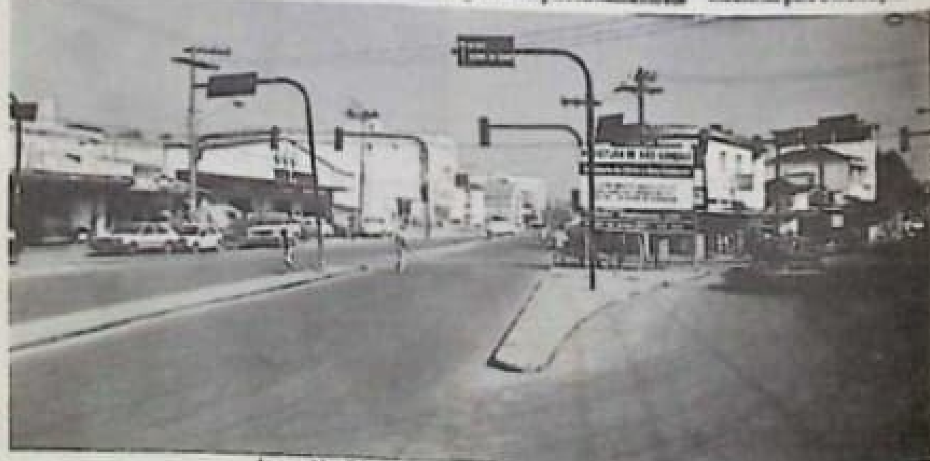
As avenidas Edson e Maria receberam recapamento asfáltico e sinalização horizontal.
