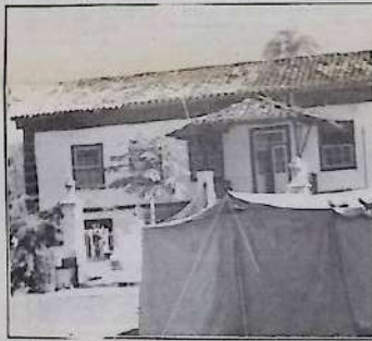
Depois de desapropriado sob vigilância da Defesa Civil
