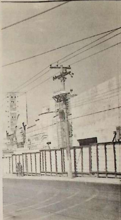
A construção do shopping Dillas é um dos pontos do desenvolvimento
