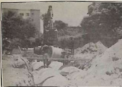
A prefeitura coloca tubos de 1 metro de diâmetro
