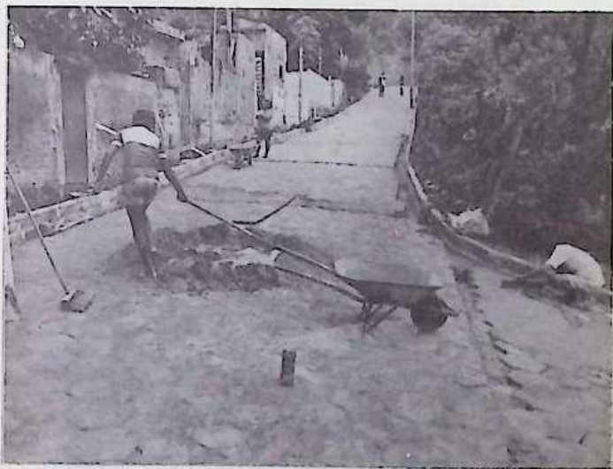
Pavimentação da Rua Eduardo Uchôa, em Tenente Jardim
