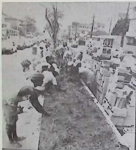
Preparação dos canteiros na rua Marquês do Paraná.
