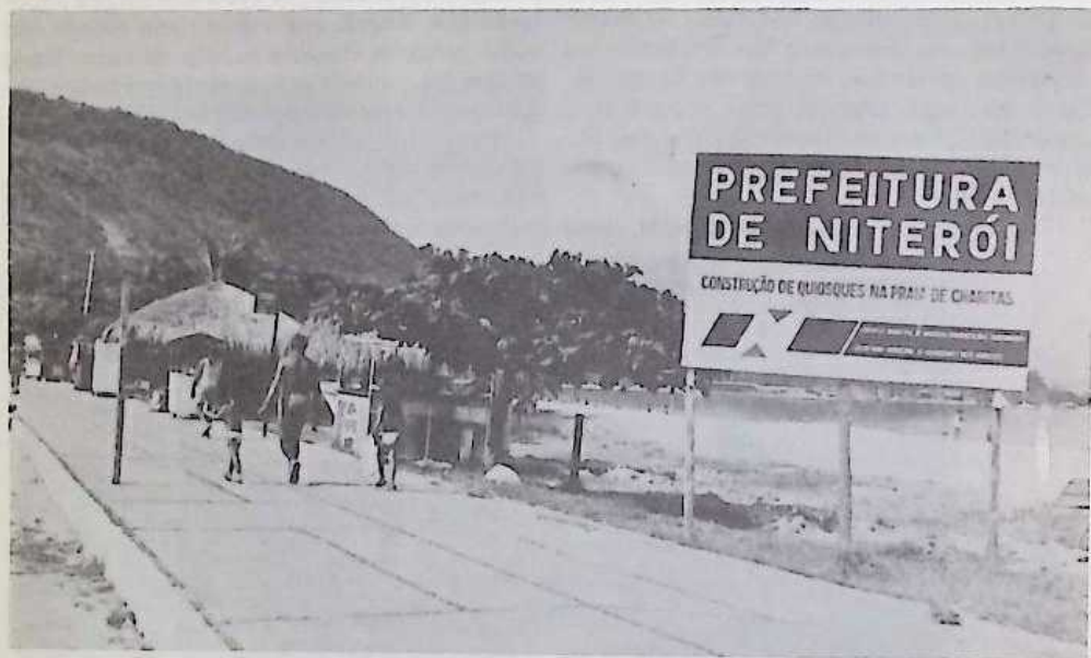
Construção do quiosque que tanto embeleza a praia das Charitas.
