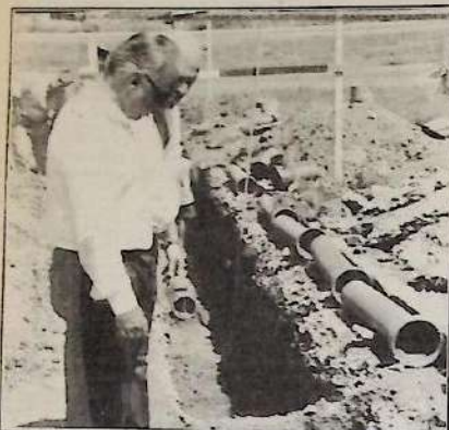
A estação está sendo feita às margens da Rodovia Niterói-Manilha
