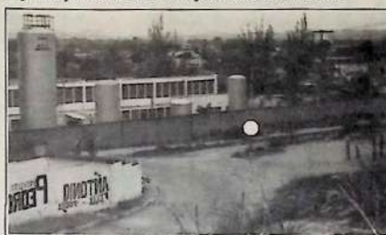
Estação de Tratamento não consegue atender a demanda do Município
