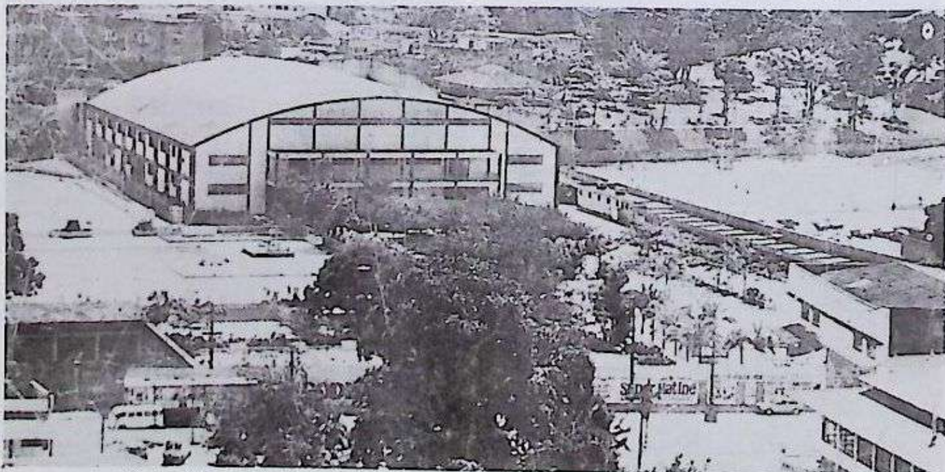
A bonita vista do grande complexo esportivo e social do Clube Esportivo Mauá: 75 mil metros quadrados.
