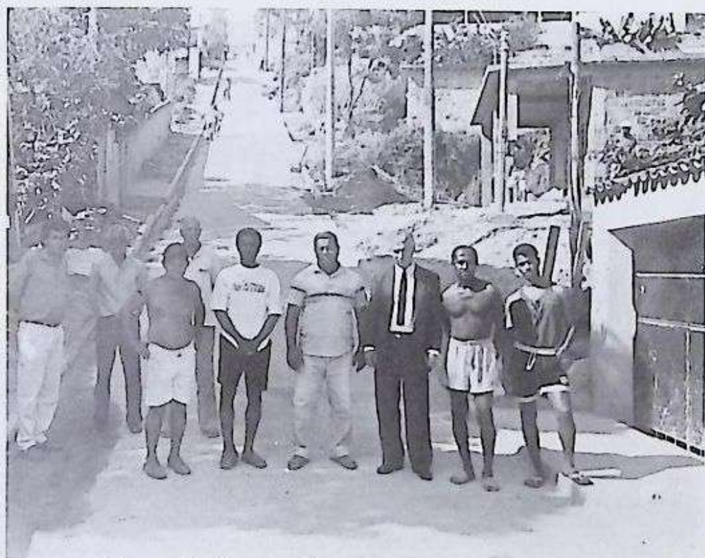
A Travessa Rio Branco, no Barro Vermelho, recebeu obras de dragagem e pavimentação.
