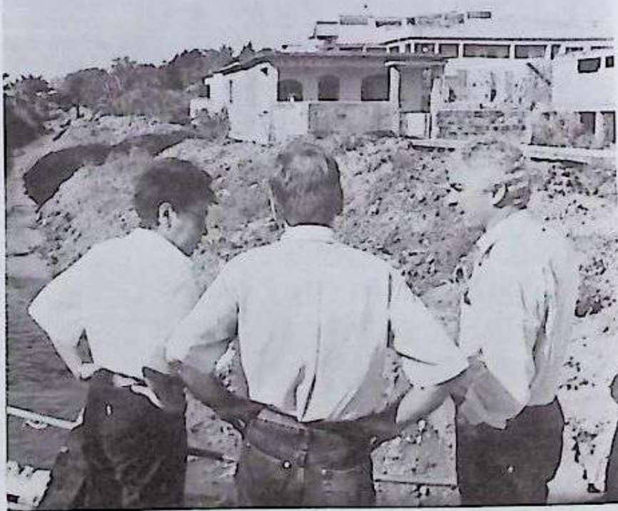
Bravo acompanha de perto as obras de dragagem do Rio Mutondo.
