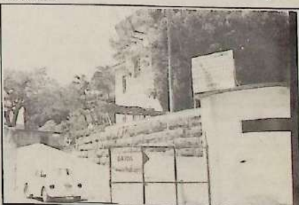
O hospital Luiz Palmier está recebendo reformas para aumentar a capacidade de atendimento da população e ainda terá um tomógrafo instalado dentro de 30 dias. Página 4
