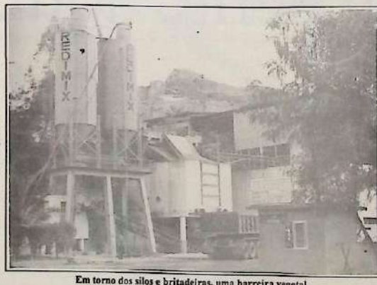
Em torno dos silos e britadeiras, uma barreira vegetal.
