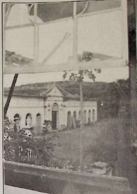
Pela janela quebrada a visão do abandono
