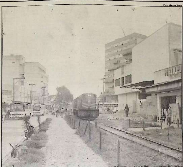
O novo corredor viário vai ser construído no leito da via férrea, na Av. Kennedy
