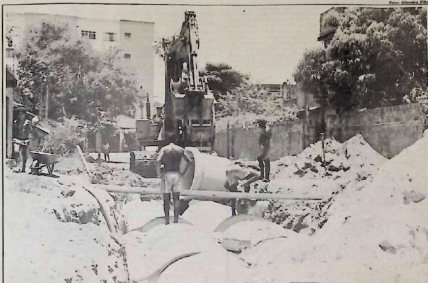
Saneamento (na foto, obras de implantação de esgotos) continua sendo primeira reivindicação do povo.
