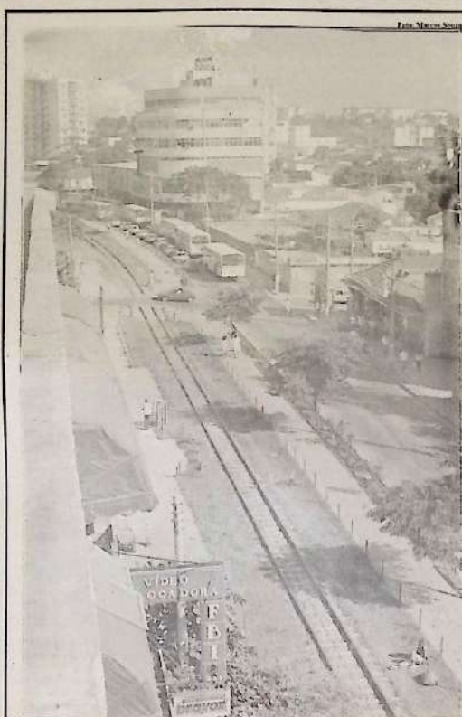
A prefeitura já iniciou inclusive as obras de alargamento da Av. Kennedy, onde o Estado pretende construir a Via Expressa
