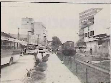
A retirada da linha férrea vai provocar a expulsão dos invasores do leito da ferrovia
