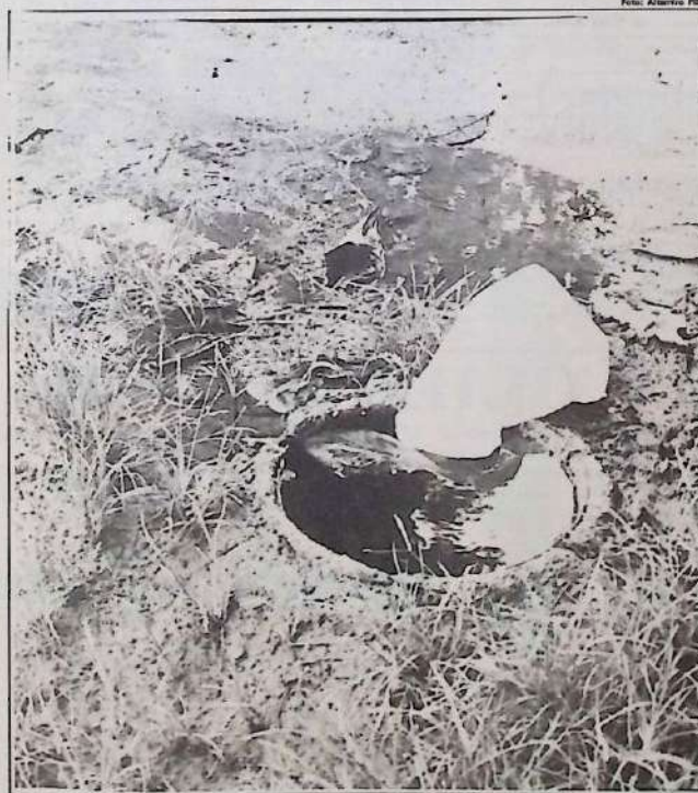
ENQUANTO falta água nas torneiras das casas, a água escorre no registro da Cedeae.
