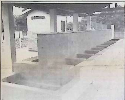
A nova lavanderia tem 22 tanques abastecidos por um poço artesiano
