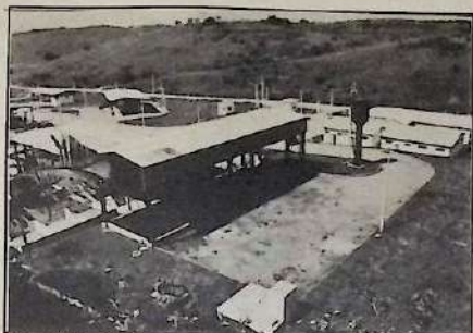
Usina de lixo de Belford Roxo. A de São Gonçalo será maior.
