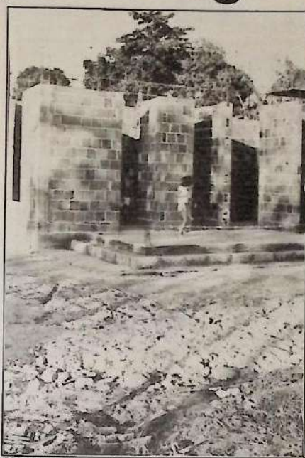
OBRA até agora irregular, poderão ser aprovadas
