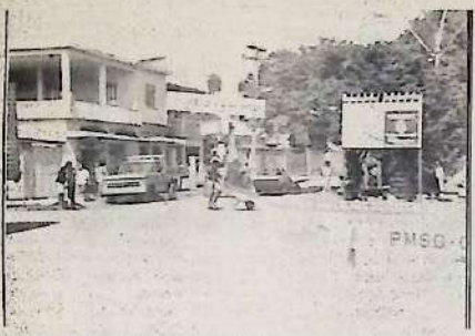
As ruas foram construídas em regime de mutirão pela Prefeitura e moradores.
