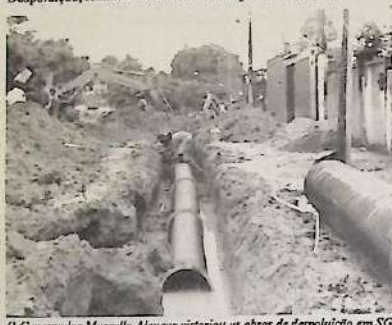
O Governador Marcello Alencar visitou as obras de despoluição em SG
