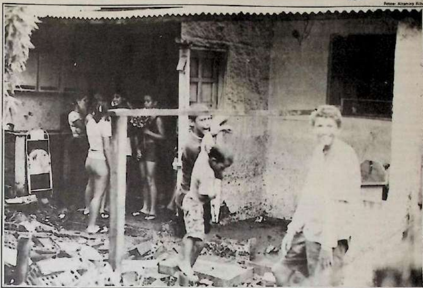
Na Travessa Simões, as águas derrubaram a parede da cozinha desta casa.
