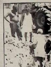
A vereadora Solange Costa esteve supervisionando as obras de melhoria de abastecimento
