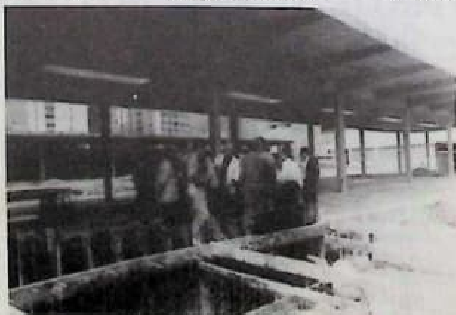
Quase concluída a Rede Mirante do Terminal Norte, que deverá ser inaugurada após o término dos melhoramentos daquela localidade. A foto nos mostra, quando o Prefeito João Sampaio fala sobre aquela obra.
