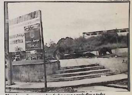
Moradores dizem que obra fecha a rua e prejudica a todos
