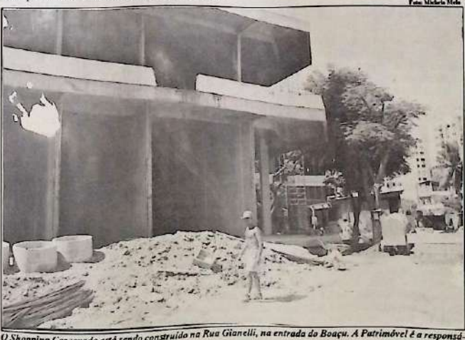
O Shopping Corcovado está sendo construído na Rua Gianelli, na entrada do Boaçu. A Patrimônio é a responsável pelas vendas
