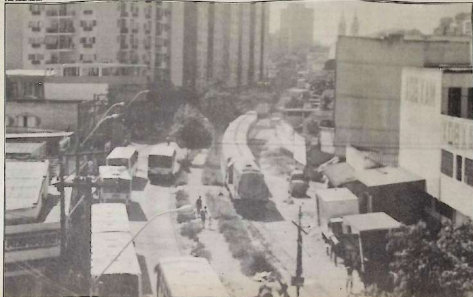
A avenida Presidente Kennedy vai ser totalmente reurbanizada e pavimentada ainda este ano, para acabar com os buracos e lombadas.
