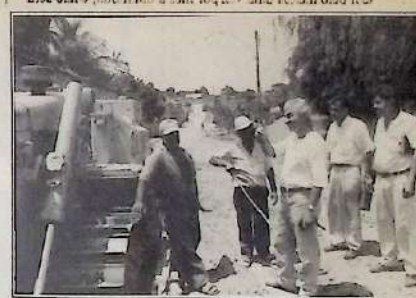
João Bravo inspeciona as obras de pavimentação da Rua Elvira das Dores
