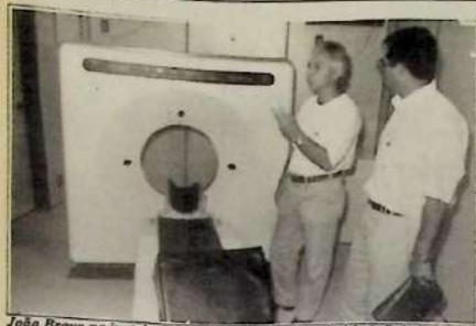
João Bravo na instalação do tomógrafo no Hospital Luiz Palmier
