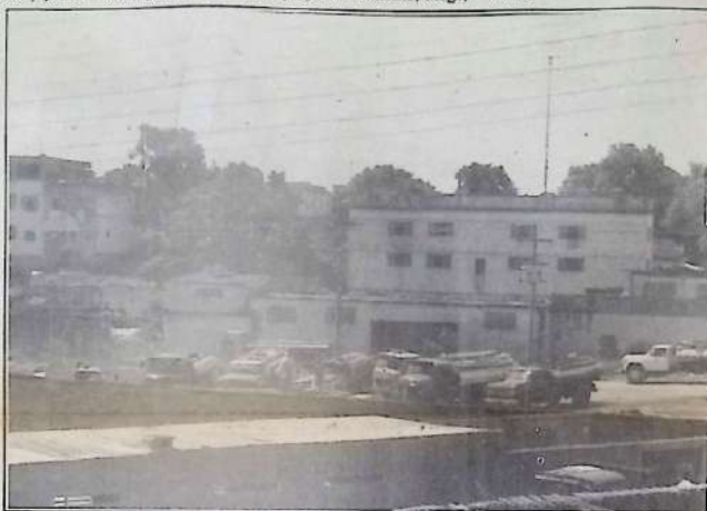
Dezenas de carros-pipas se abastecem diariamente nos hidrantes do bairro
