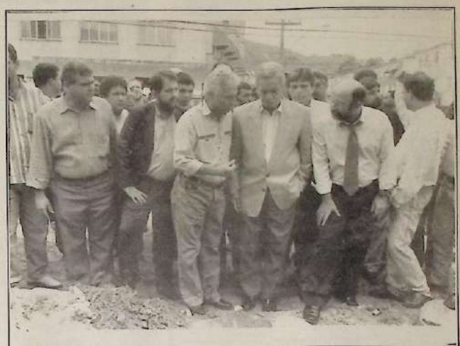
Marcelo e comitiva inspecionam as obras do Programa de Despoluição da Baía iniciadas no bairro do Rocha
