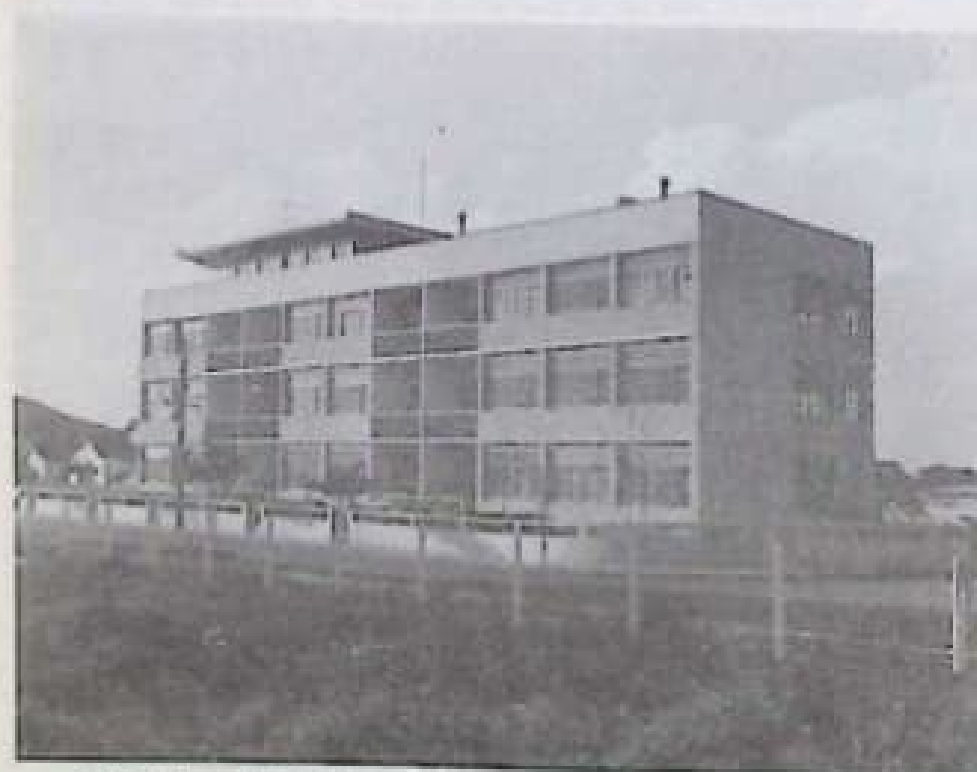
O edifício de Cabo Frio, o primeiro daquela cidade construído pela Construtora Tamoio.
