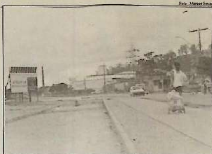
A obra da ciclovia de Neves está paralisada há meses
