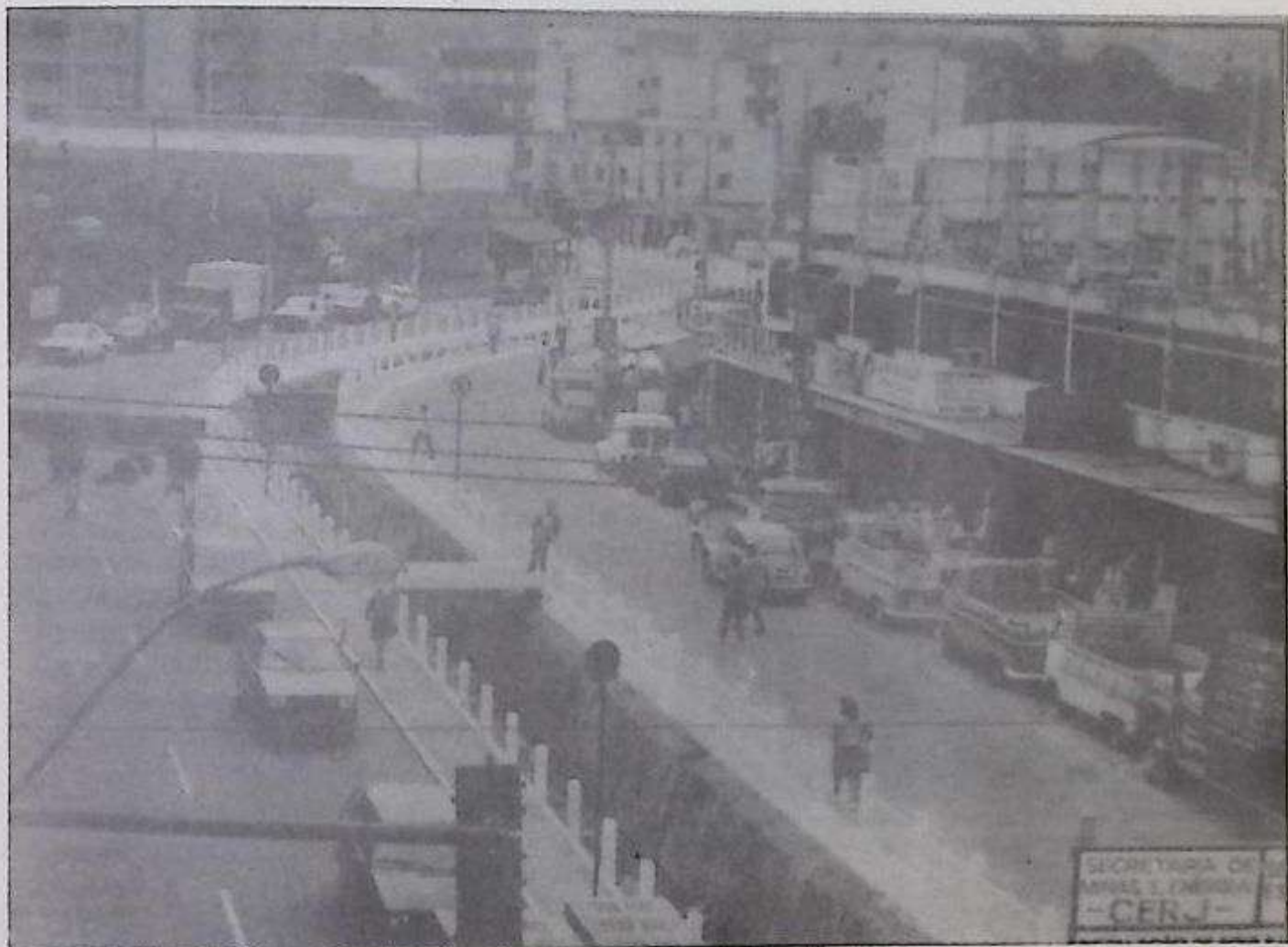
O canal da Vila Três ganhou mais uma ponte, grades de proteção e teve as margens urbanizadas
