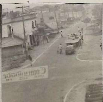
Ruas e travessas de diversos bairros foram drenadas e pavimentadas. Na foto, a Estrada da Trindade.
