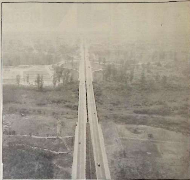
Invasores constroem as margens da Rodovia Niterói-Manilha, na área do Patrimônio da União
