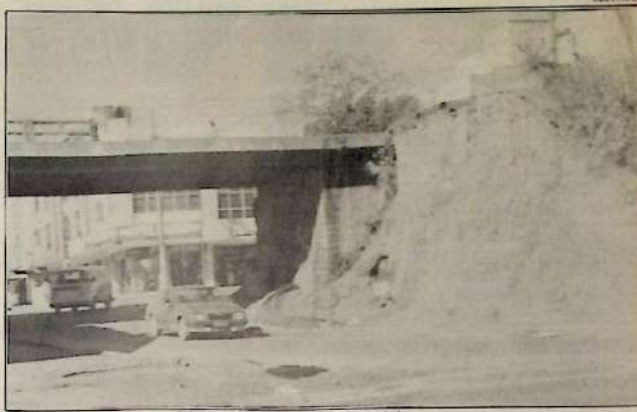
O novo retorno está sendo feito no trecho sobre a Avenida Maricá
