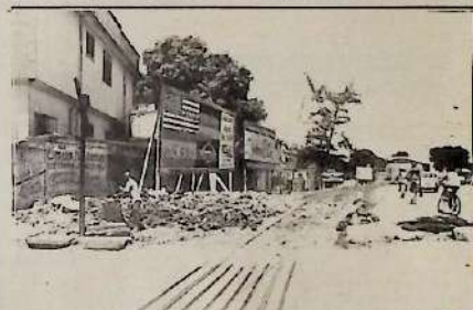
As placas foram retiradas porque estavam atrapalhando a visão dos maquinistas
