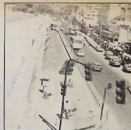
As obras no viaduto estão paralisadas há mais de um ano
