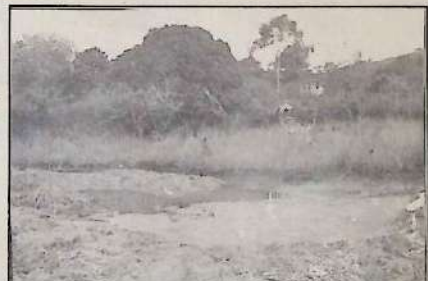
O pólo seria construído em Guaxindiba, às margens da Rodovia Niterói-Manilha
